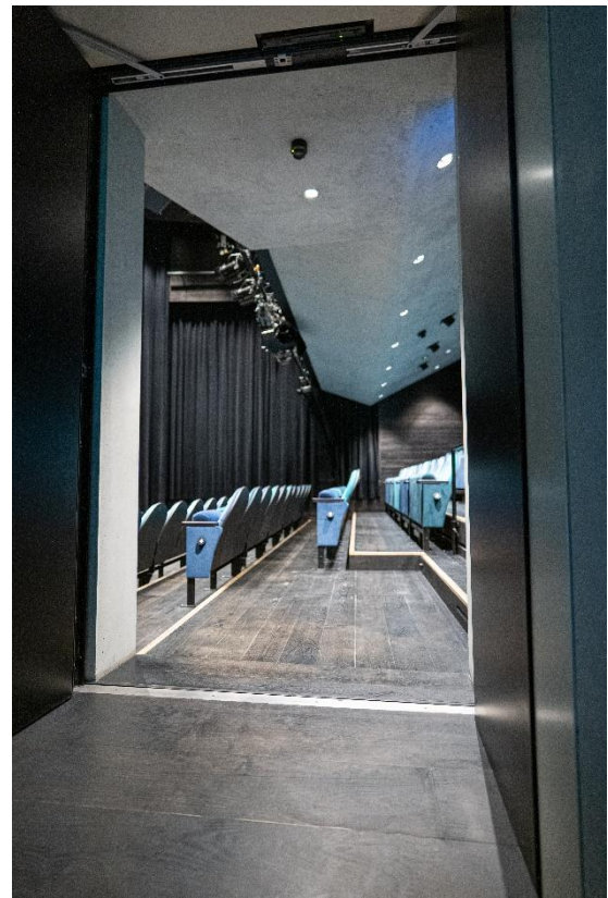
Abbildung 2: Zugang zum großen Saal im Obergeschoss: Türöffnung mit flachem Übergang, direkt dahinter der Rollstuhlplatz. Diesen umgebend die Sitzreihen. Foto: © KOLK 17
