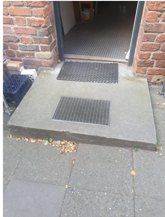
Abbildung 2: Boden beim Zugang über den Hinterhof (über Gerade Querstraße). Vor der Tür befindet sich ein Betonpodest von etwa 6 cm. Die Stufe kann mithilfe einer Rampe bewältigt werden.
