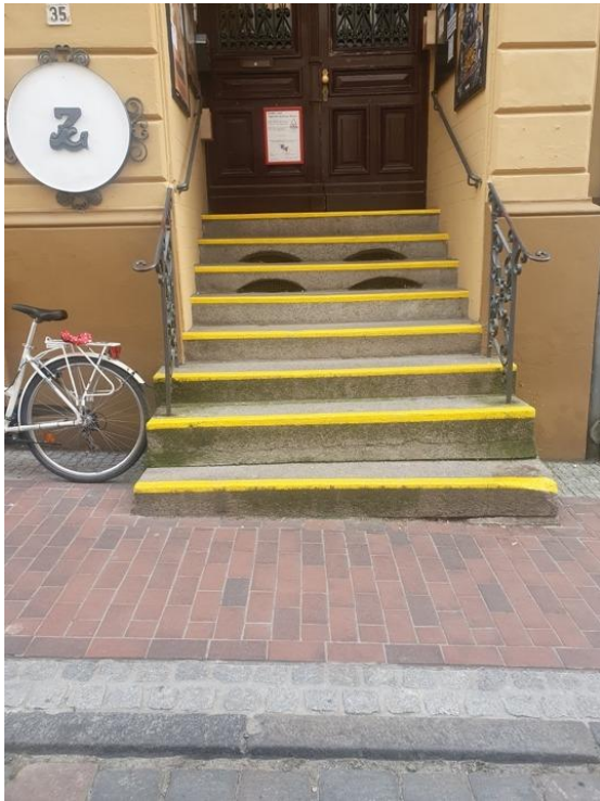
Abbildung 1: Haupteingang in der Mengstraße: 8 Stufen mit gelb markierten Kanten und Handläufen auf beiden Seiten. Eine Rampe ist nicht vorhanden.
