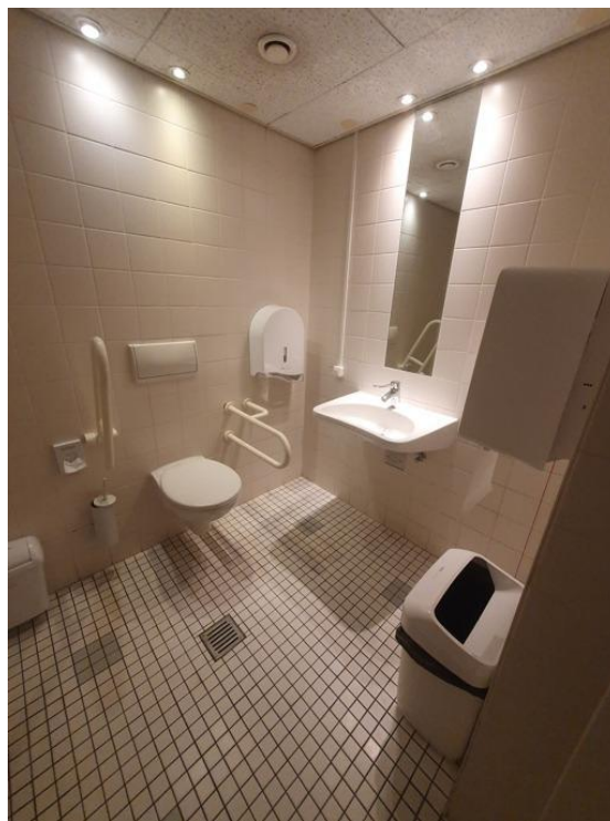
Abbildung 8: Innenraum der barrierearmen Toilette mit Haltegriffen, unterfahrbarem Waschbecken und tief angebrachtem Spiegel.
