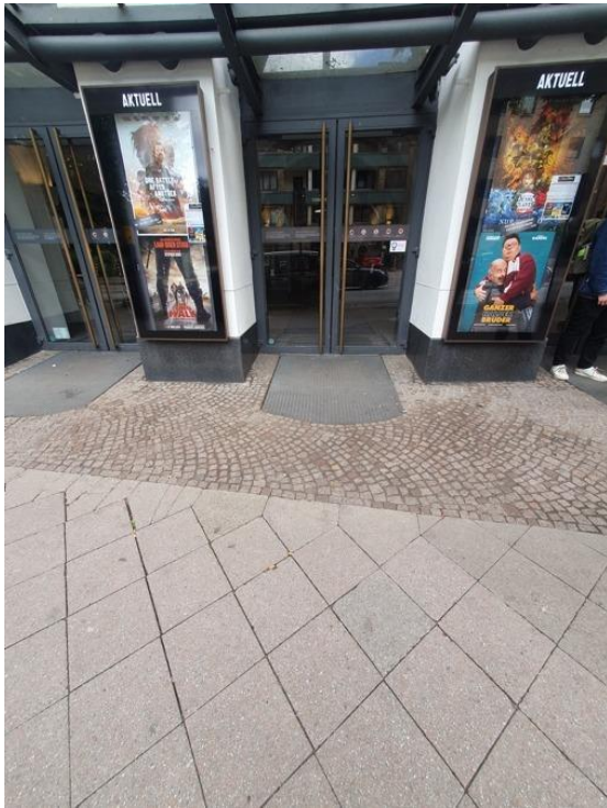
Abbildung 1: Der Haupteingang an der Mühlenbrücke. Der Vorplatz ist gepflastert, der Zugang erfolgt stufenlos. Die Türen öffnen nicht automatisch.
