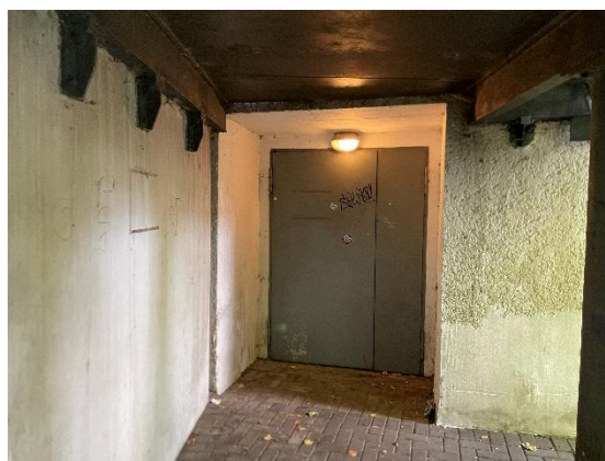
Abbildung 16: Blick auf die Notausgangstür von Saal 4 von unterhalb der Feuerschutz-Treppe. Unmittelbar dahinter liegt der Saal 4 mit fünf Rollstuhlplätzen vor der Reihe 1.
